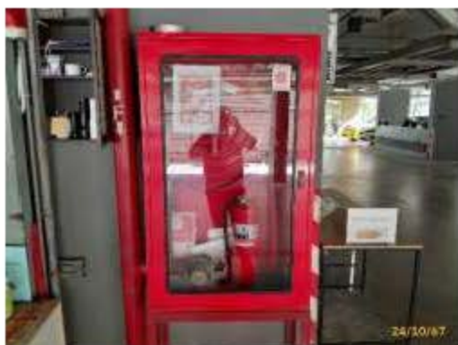
ตู้เก็บสายฉีดน้ำดับเพลิงและท่อยื่น
